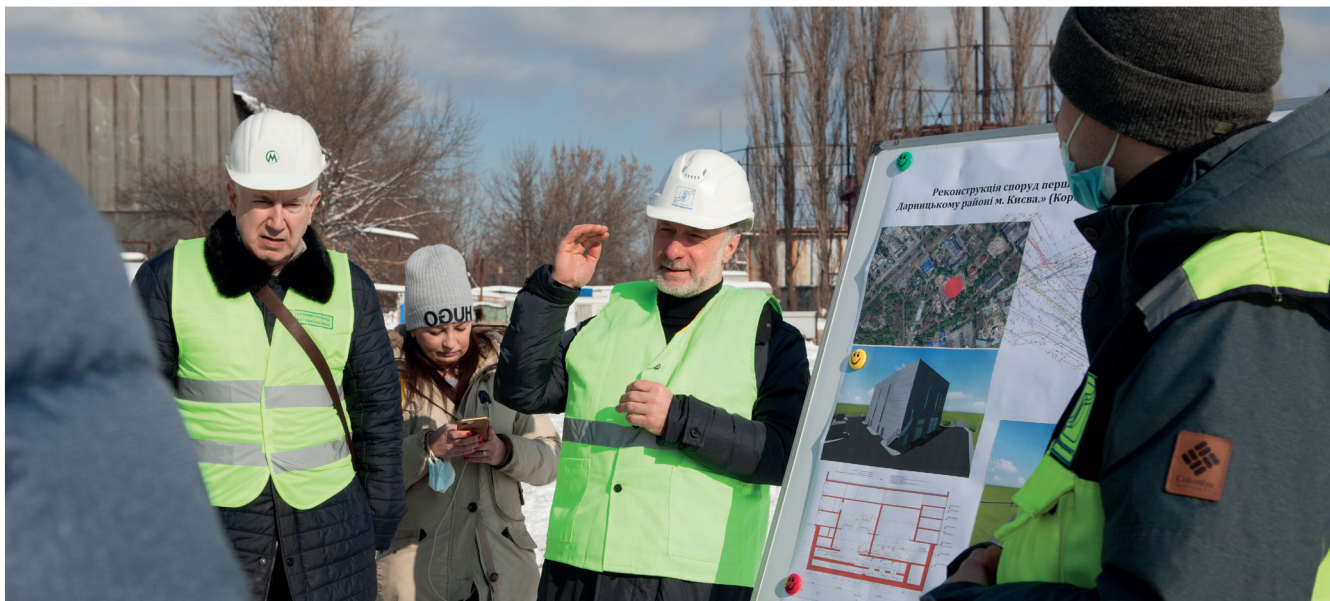
Д. Новицький, депутати Київради та члени комісії з питань ЖКГ проінспектували хід робіт з будівництва станції 1 підйому БСА
